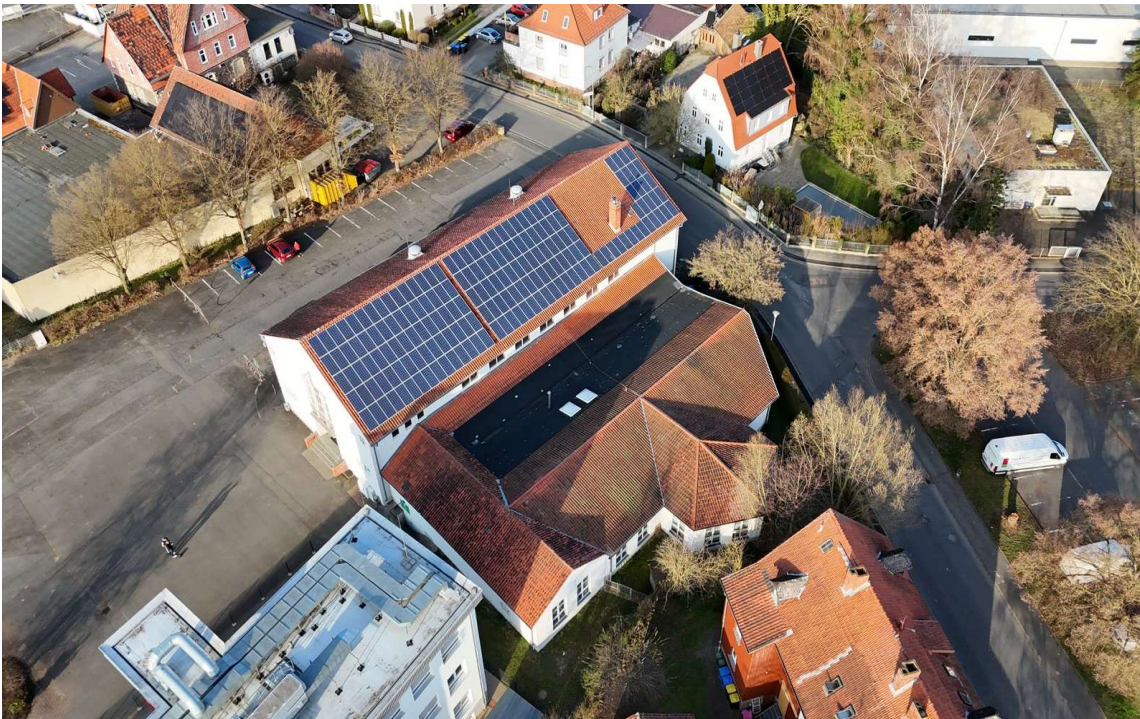
Luftaufnahme des Anbaudaches mit den bestehenden Photovoltaikanlagen auf dem Hauptgebäude.
